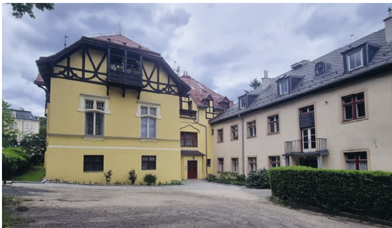
Bývalé Varieté Karla Meiningera v Riegrově ulici č. p. 1280
