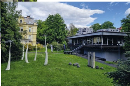
Masarykova třída č. p. 542 a bývalý pavilon Bytenu
