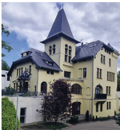
Bývalé Breyovo sanatorium
