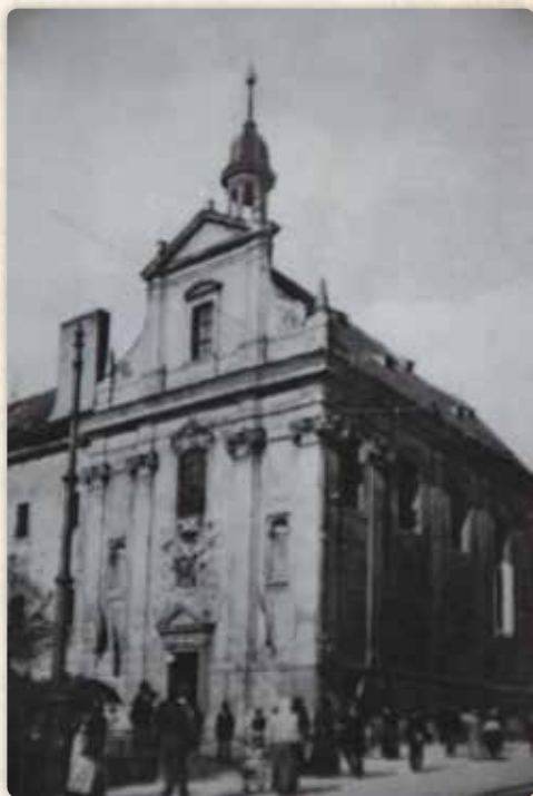
Kostel svatého Vojtěcha od Celetné ulice (1902). Svatyně byla nejprve součástí arcibiskupského semináře, pak sloužila jako pražský posádkový kostel... Ani to ji neuchránilo před zbořením
