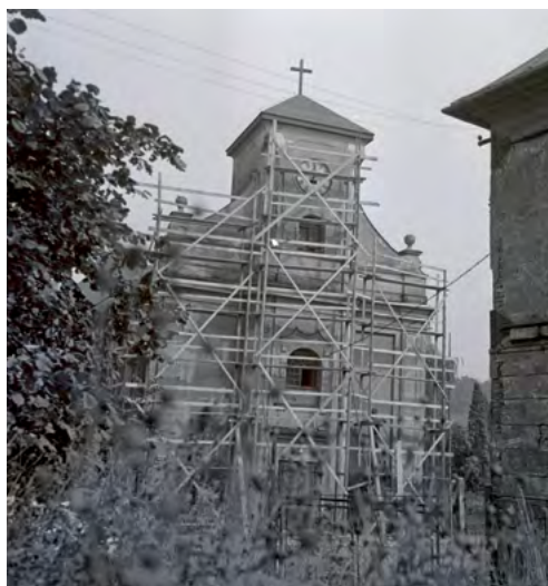
↑ Rekonstrukce kostela v roce 1961, napravo roh bílé školy. Foto: Z fondů Národního památkového ústavu
