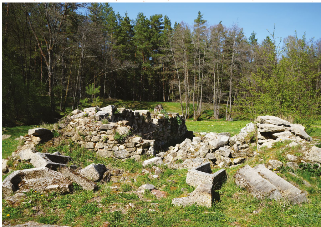
↑ Obvodové zdi stavení kdysi náležejícího k budově mlýna.
