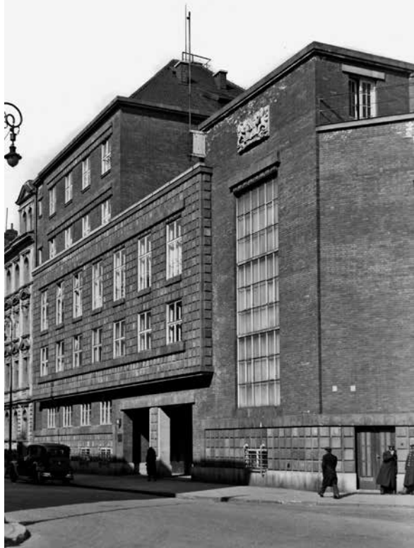
Hlavní budova čs. vyslanectví ve Varšavě na ulici Koszykowa 18. Budovu zakoupila československá vláda v roce 1921 a v letech 1927–1928 ji nechala přestavět do modernistického stylu. Nejvýraznějším prvkem tehdejší fasády byl reliéf velkého znaku Československé republiky (NAC).
