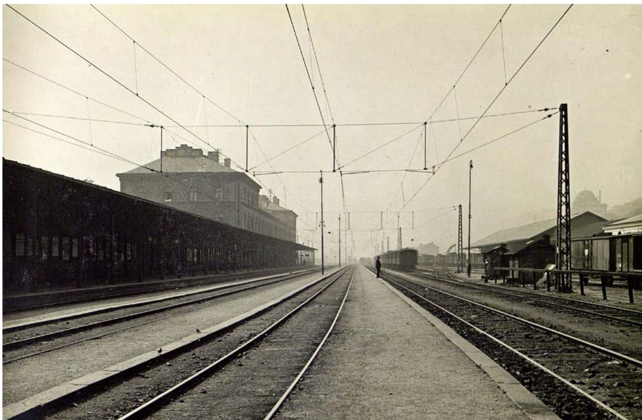
Trakční vedení ve stanici Praha-Smíchov. Zdroj: Státní oblastní archiv v Plzni, fond Škoda
