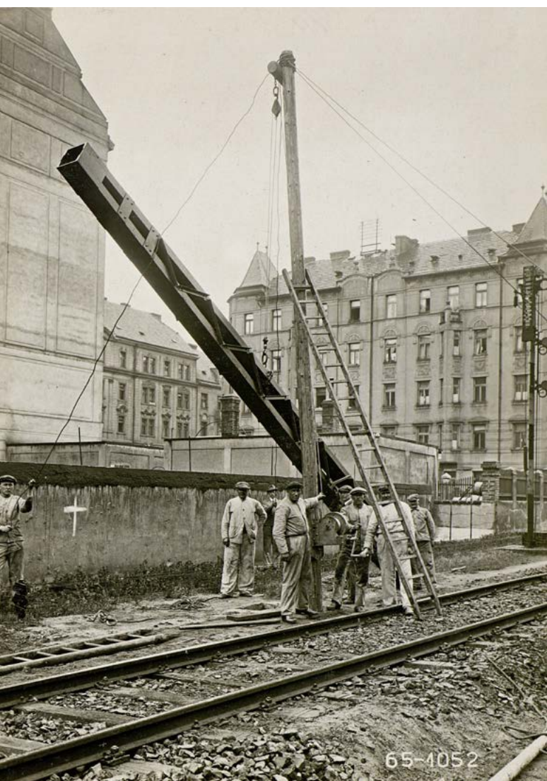
Vztyčování příhradového stožáru pomocí vrátku na trati v Praze dne 25. 4. 1927. Zdroj: Státní oblastní archiv v Plzni, fond Škoda
