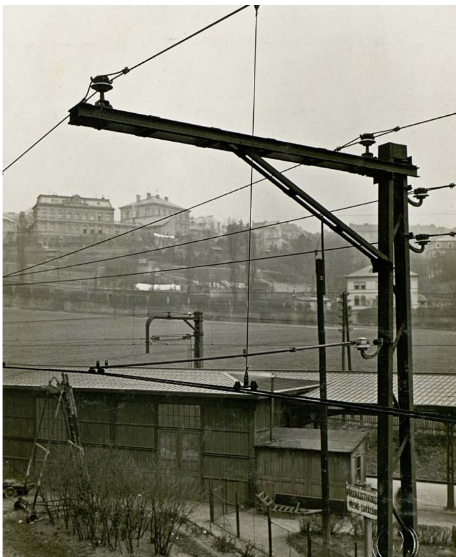
Trakční vedení v úseku Vyšehrad–Nusle. Zdroj: Státní oblastní archiv v Plzni, fond Škoda
