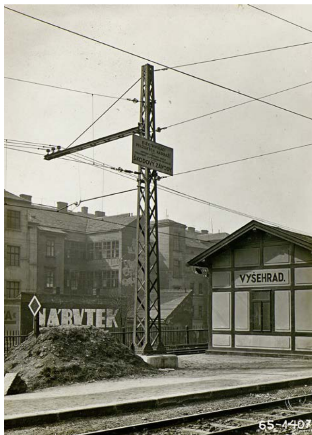
Trakční vedení ve stanici Praha-Vyšehrad, na stožáru reklamní tabule Škodových závodů. Zdroj: Státní oblastní archiv v Plzni, fond Škoda
