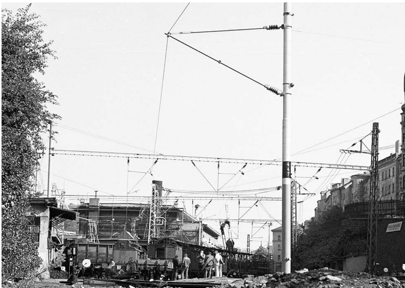
Pohled na původní měnírnu Křenovka v roce 1976, kdy probíhala rekonstrukce trakčního vedení. V té době zde již místo nabíjecích míst akumulátorových lokomotiv bylo stanoviště pojízdných měníren. Archiv EŽ Praha
