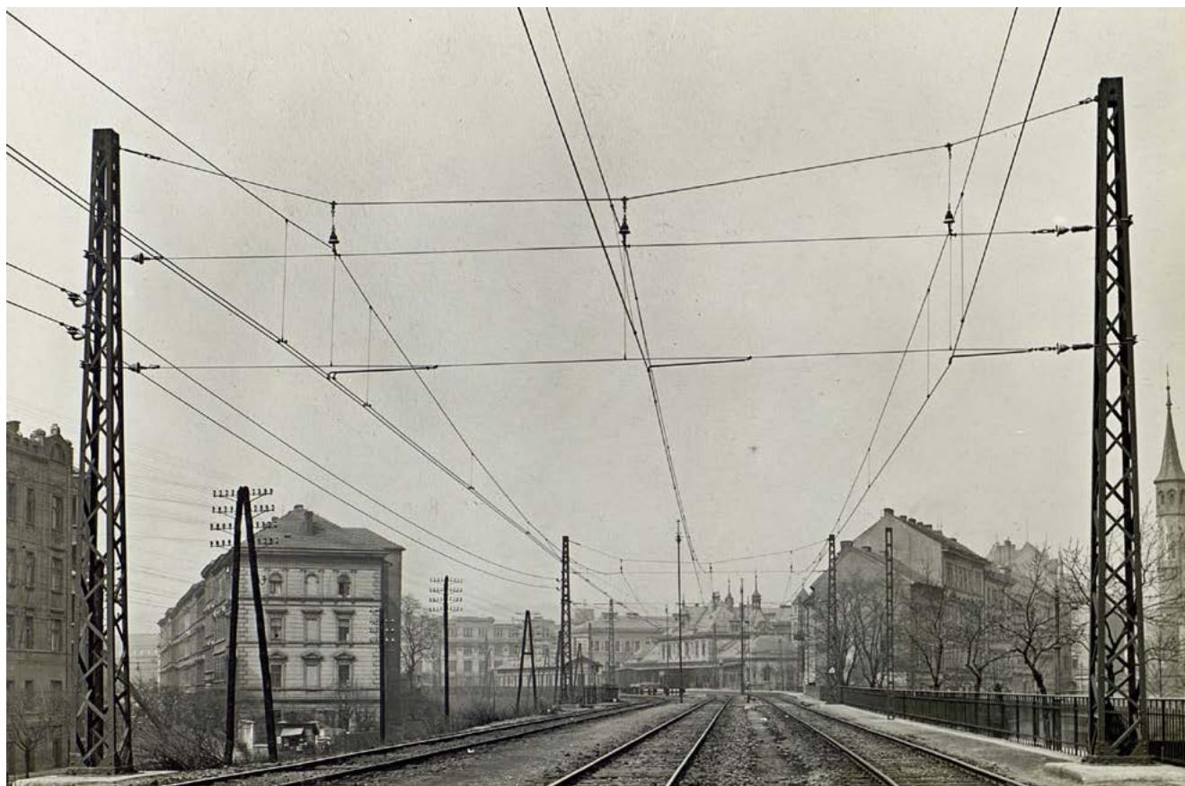
Trakční vedení ve stanici Praha-Vyšehrad, pohled od Nuslí. Zdroj: Státní oblastní archiv v Plzni, fond Škoda
