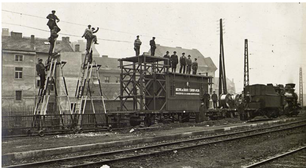
Tažení trolejového vedení ve stanici Vršovice-Nusle. Zdroj: Státní oblastní archiv v Plzni, fond Škoda
