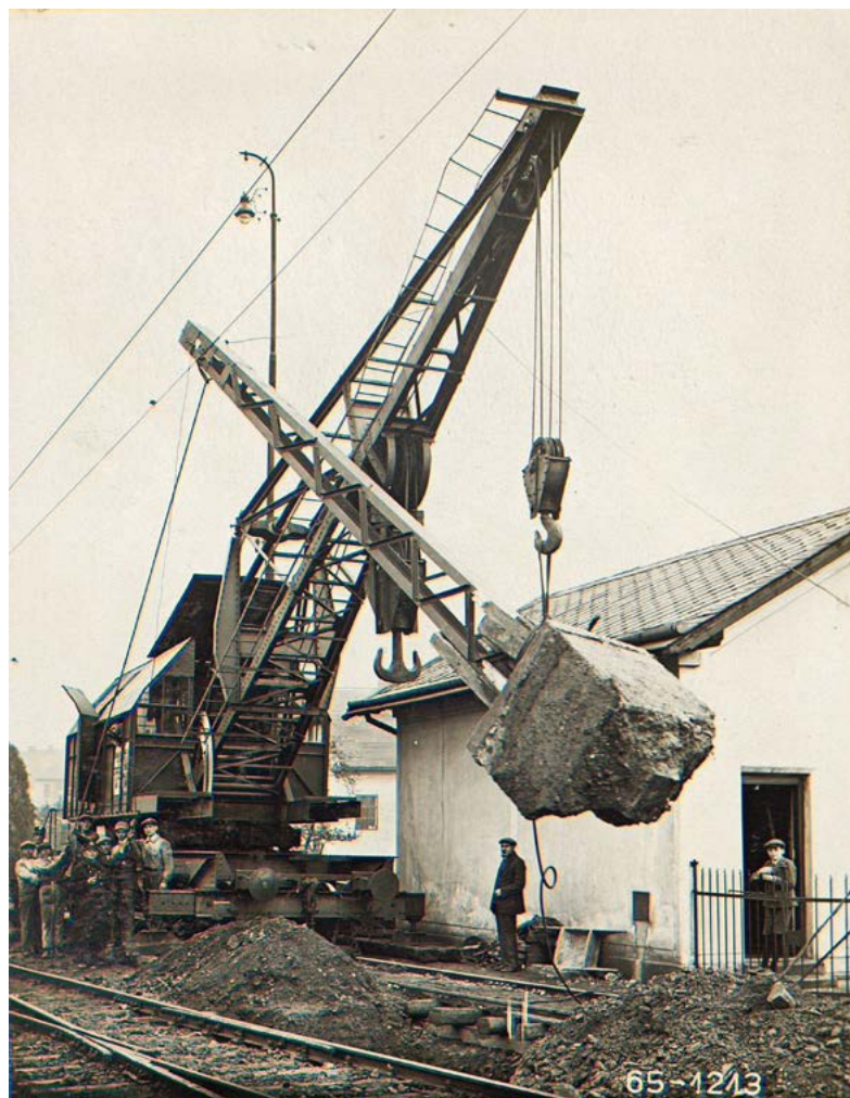
Demontáž příhradového stožáru se zlomeným základem pomocí kolejového jeřábu, Praha 1927. Zdroj: Státní oblastní archiv v Plzni, fond Škoda
