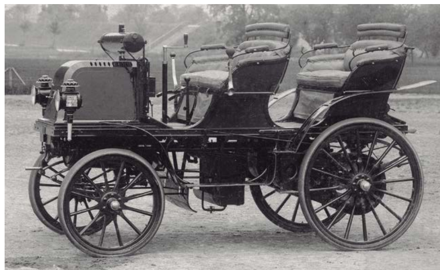
Vůz Daimler Phoenix, 1898–1902. Motor byl poprvé umístěn vpředu
