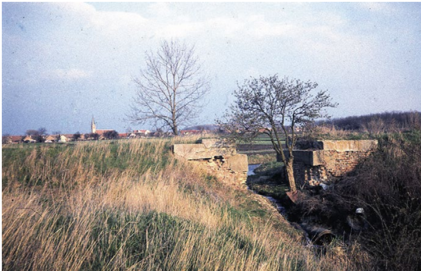
Traťový úsek Novosedly – st. hranice, opěry můstku přes Bystřický potok, v pozadí obec Nový Přerov, 13. dubna 1994, foto Jiří Marek.
