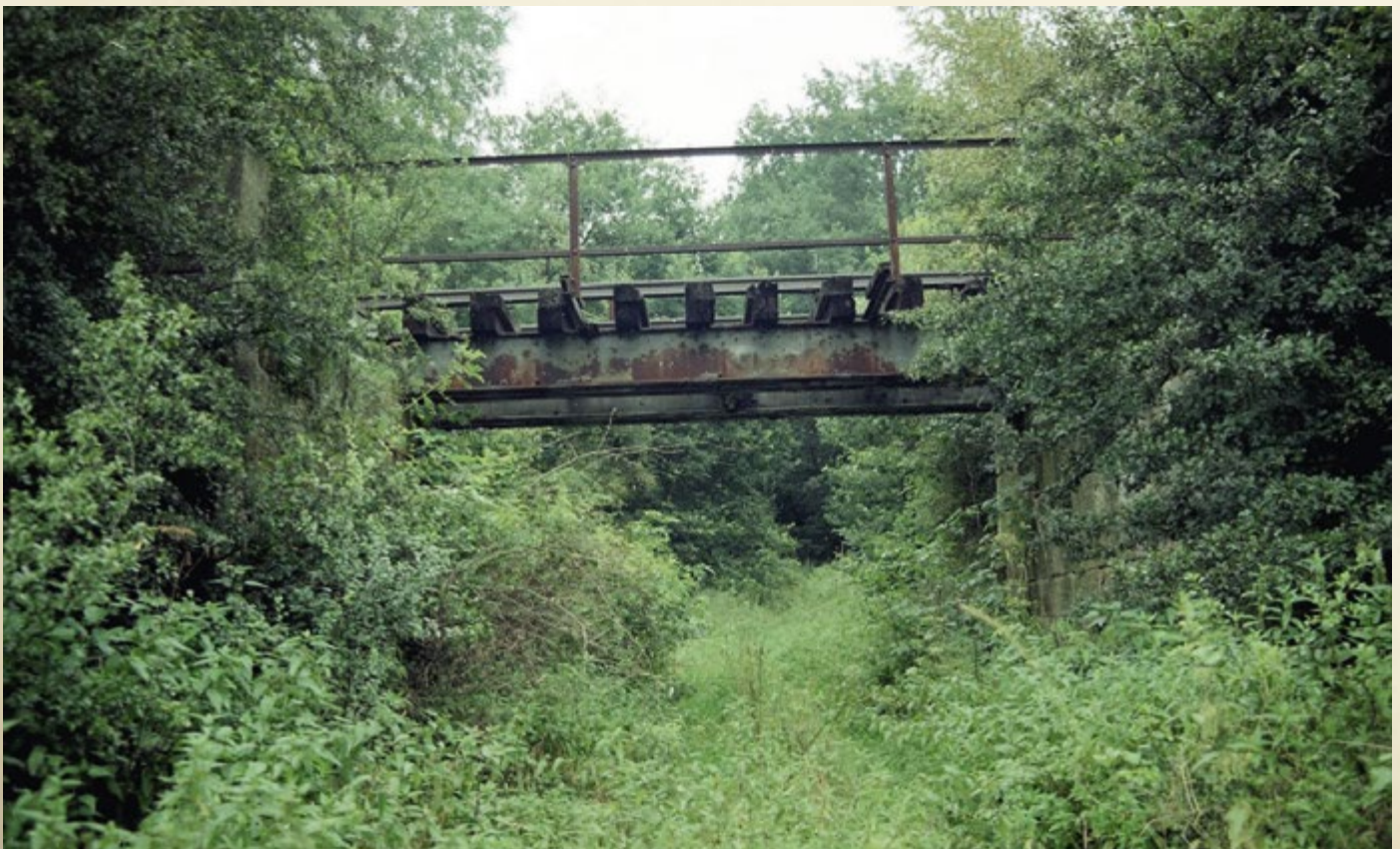
Most mezi Slapany a státní hranicí v km 20,407, pohled ze stejné strany jako na předchozím snímku, v srpnu 1997 zde již nebyly zátarasy, foto Petr Ovsenák.
