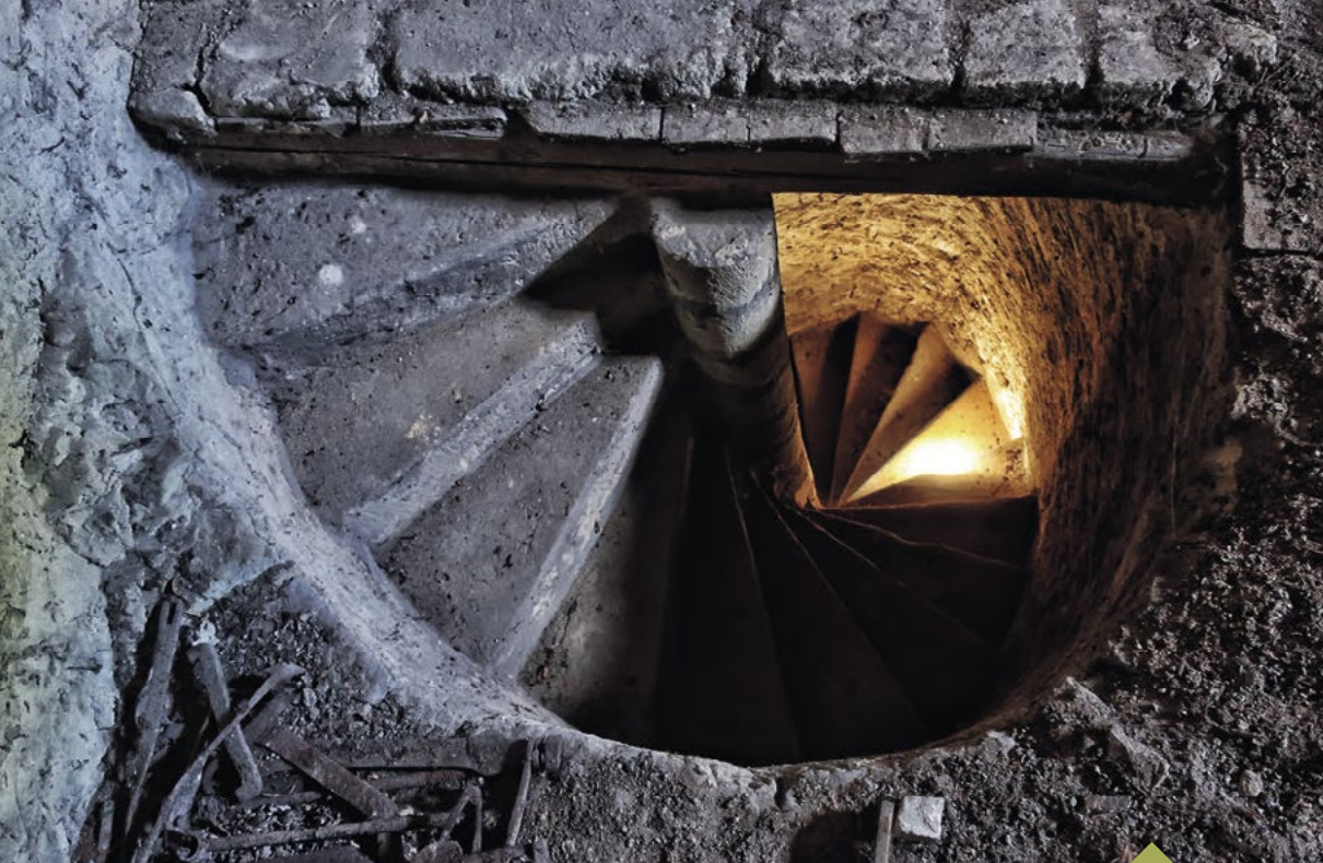
Schody na půdu středověkého kostela v Lobkovicích
