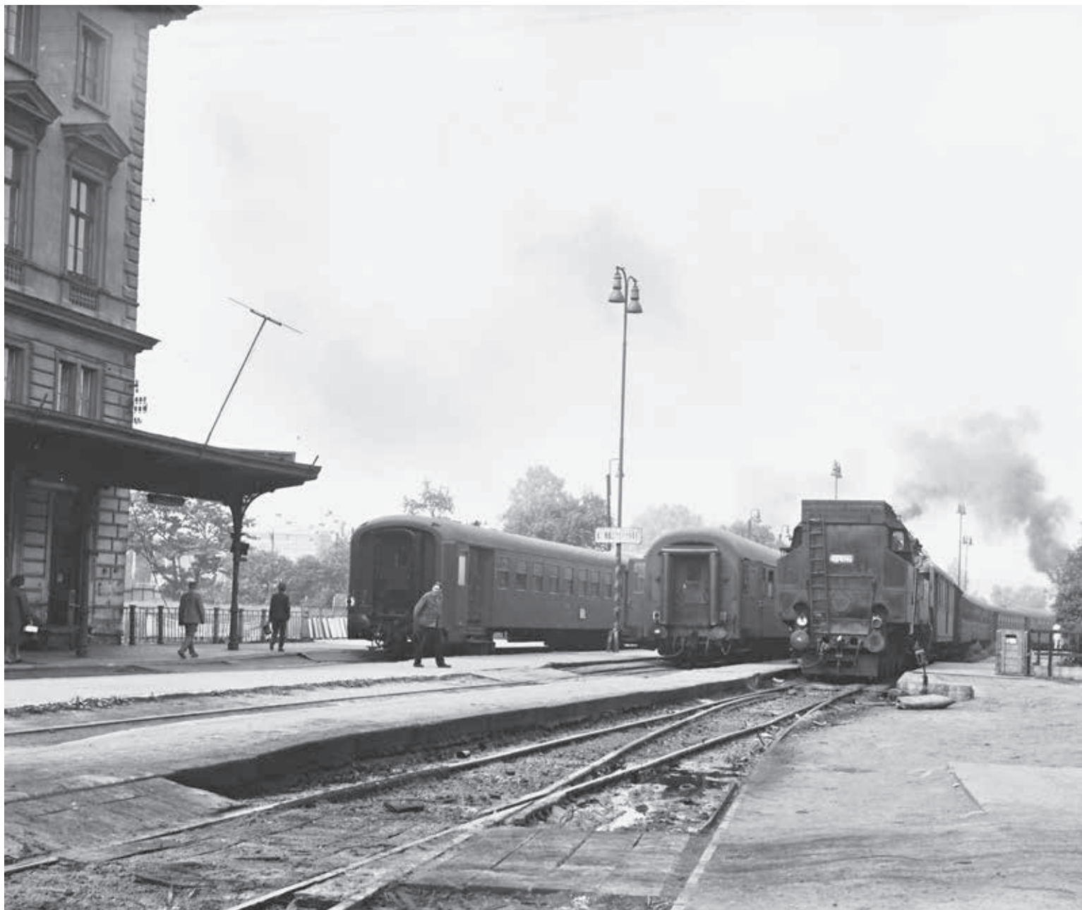
Pohled na nástupiště Nádraží Praha Těšnov, 4. 6. 1972. V posledních letech provozu vlaky nestávaly přímo před budovou. První a druhá kolej od budovy sloužily převážně pro odjezd vlaků a třetí kolej pro příjezd, sbírka Zdeněk Bek.
