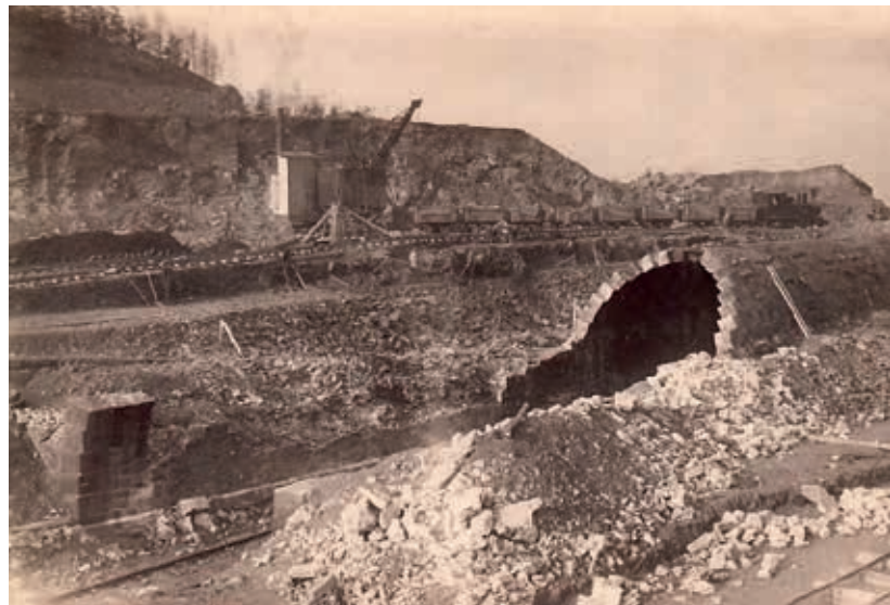
Při likvidaci tunelu pod Bohdalcem pomáhala v roce 1929 i úzkorozchodná drážka s parní lokomotivou. Sbíрка Josef Bosáček.
