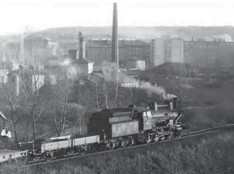
Pracovní vlak na trati Praha Vysočany - Praha Libeň dolní nádraží těsně před mostem přes Rokytku. V pozadí je ještě pracující lihovar, který v současnosti připomíná pouze Lihovarská ulice. Na místě lihovaru dnes stojí sídliště, foto Petr Roučka.
