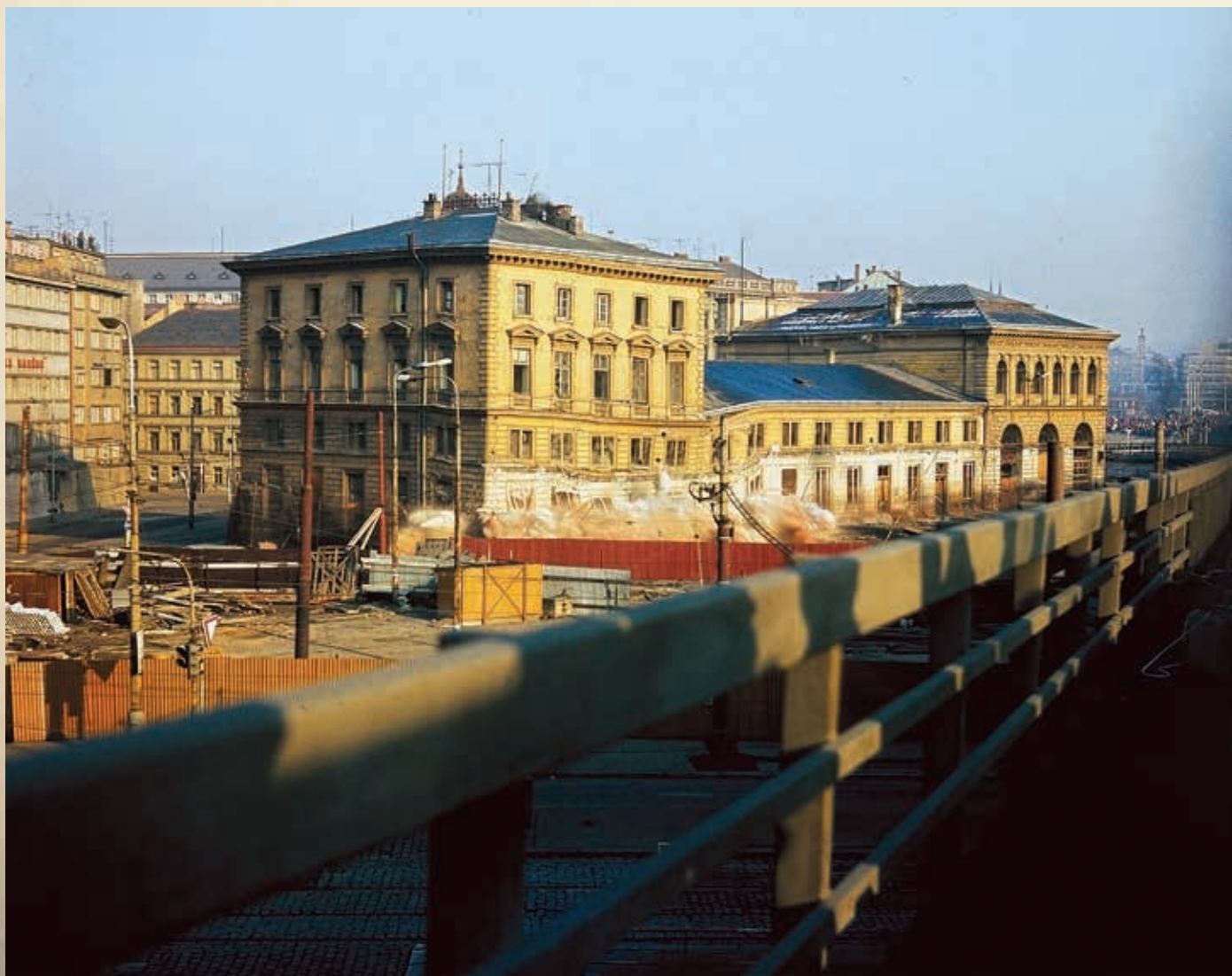
Demolice nádražní budovy Těšnov, 16. 3. 1985, foto Josef Bosáček.
