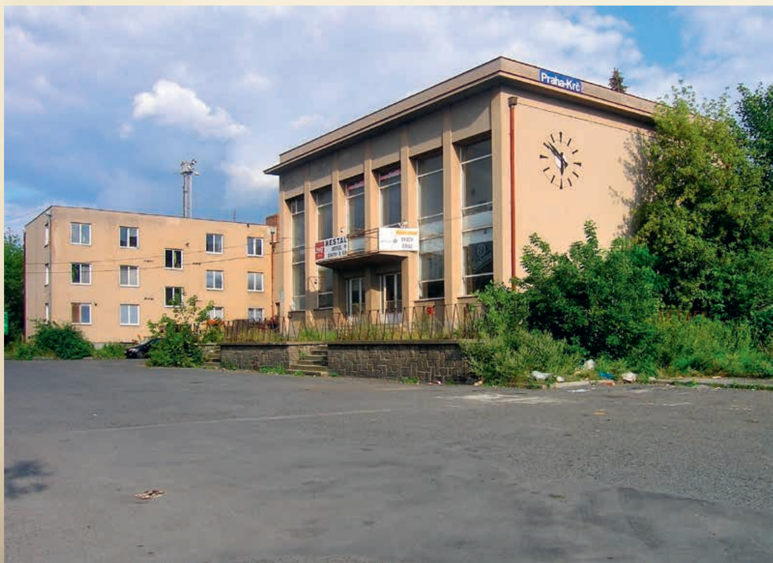
Nádraží Praha-Krč, příchod pro cestující. Budova dnes stojí na severní straně kolejíště, které bylo posunuto západním směrem, archiv SUDOP PRAHA.
