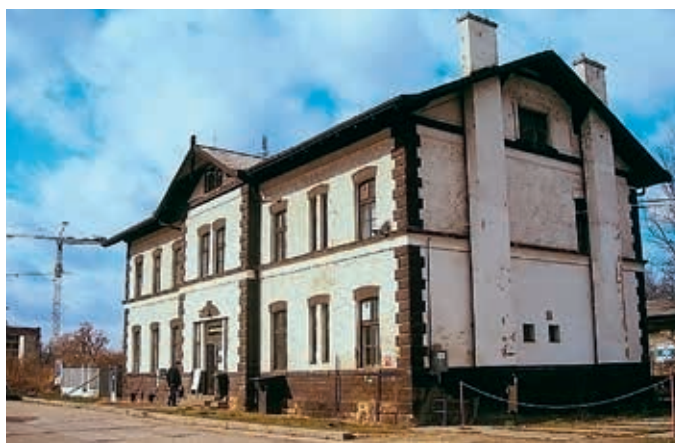
Budova nákladního nádraží na Rohanském ostrově je jednou z mála zachovaných památek na kdysi živé nádraží. Dnes je spoulu s přilehlým skladem obklopena moderními komerčními stavbami, archiv SUDOP PRAHA.
