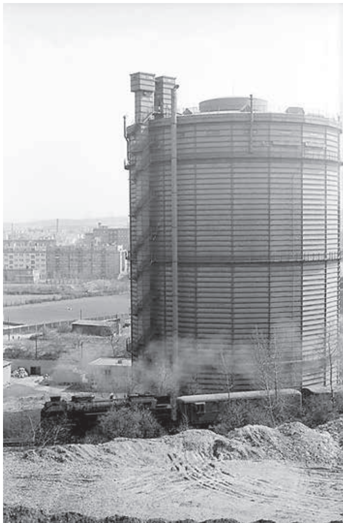
Válcový plynojem byl dominantou této části Libně od roku 1944 do roku 1981, kdy byl odstřelen a sešrotován. Trať z Těšnova do Vysočan vedla v jeho blízkosti. Na obrázku lokomotiva 464.0 s osobním vlakem překonává prudké stoupání od Balabenky. Foto Josef Bosáček 12.4.1971.
