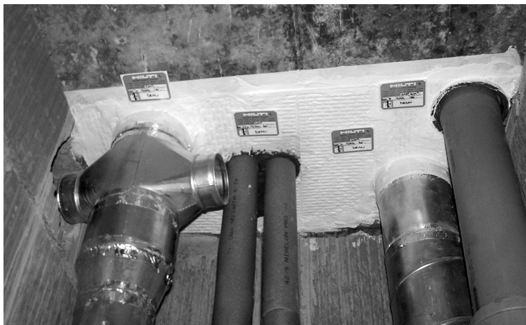
Obr. 4 Protipožární ucpávka prostupů trubních vedení stropem bytového jádra
