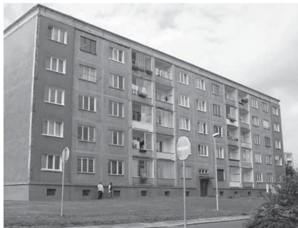
Obr. 4.1 Průčelí domu panelové soustavy G 57
