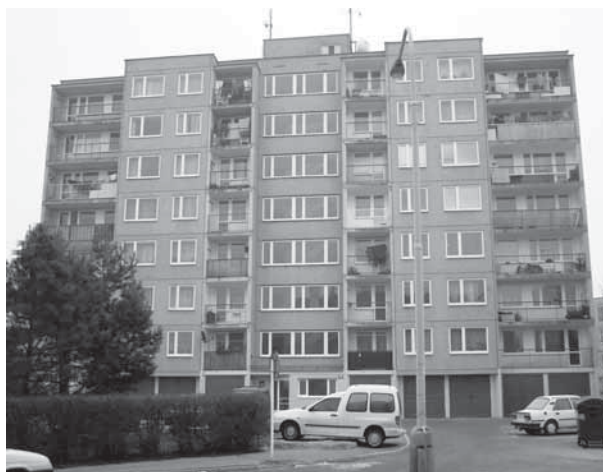
Obr. 4.9 Průčelí domu soustavy VVÚ-ETA
