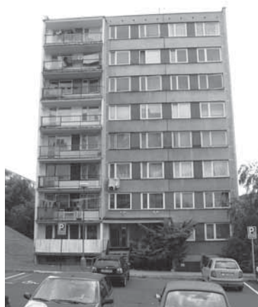
Obr. 4.8 Průčelí domu soustavy T 08 B
