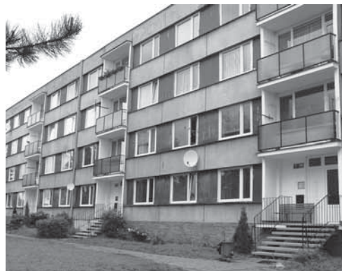
Obr. 4.7 Průčelí domu soustavy T 06 B
