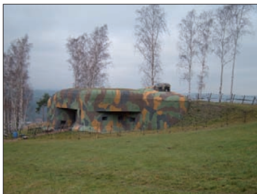
Běloves – srub Březinka
